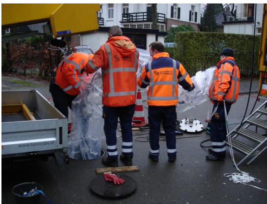
Relinen: hier het inbrengen van de 'UV-lichttrein' voor uitharding...
