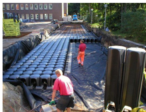
Aanleg van ondergronds infiltratieveld bij het Hoornbeeck College in zomer 2007
