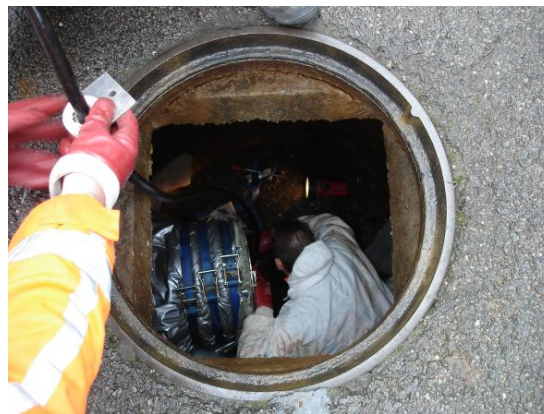
... van de glasvezelliner in het te renoveren riool aan de Berkenweg in december 2009
