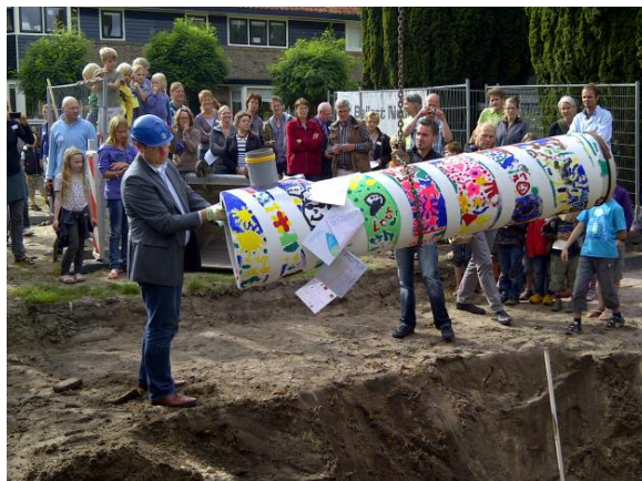
De 1.000.000 e meter Amersfoorts riool gaat in de Hobbemastraat de grond in
